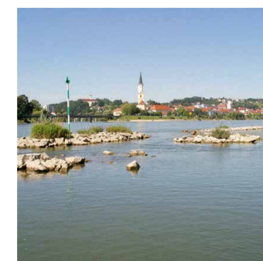
Fischökologisch optimiertes Parallelwerk
