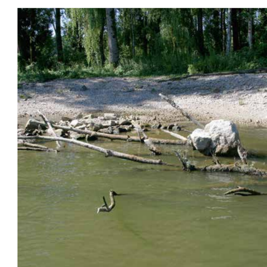
Uferrückbau mit Wellenschlagschutz
