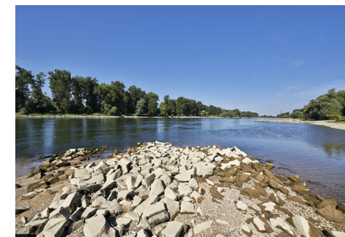
▲ Buhnen als Teil des flussregelnden Ausbaus
