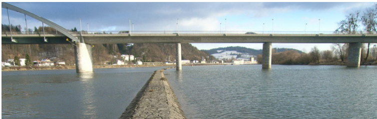
Neubau und Anpassung von Parallelwerken und Ufervorschüttungen
