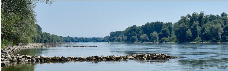
Neubau und Anpassung von Buhnen
