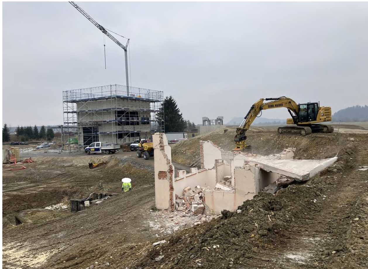
Neubau Schöpfwerk Entau im Hintergrund Abbruch Bestandsbauwerk im Vordergrund
